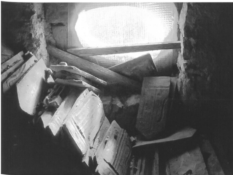
Reste der 10000 handgemachten Ziegel aus Leidikon und Laufenburg lagern noch auf dem Räche , dem obersten begehbaren Boden unter der First.
