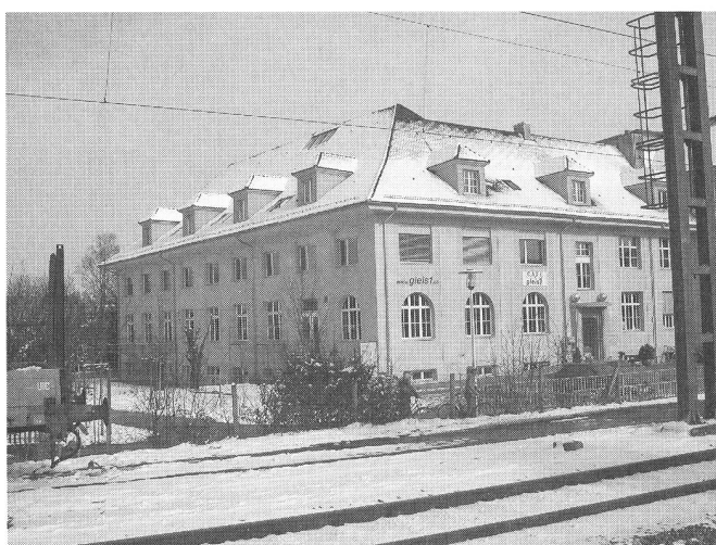
Gleis 1 in Lenzburg – vormals Kartonfabrik
