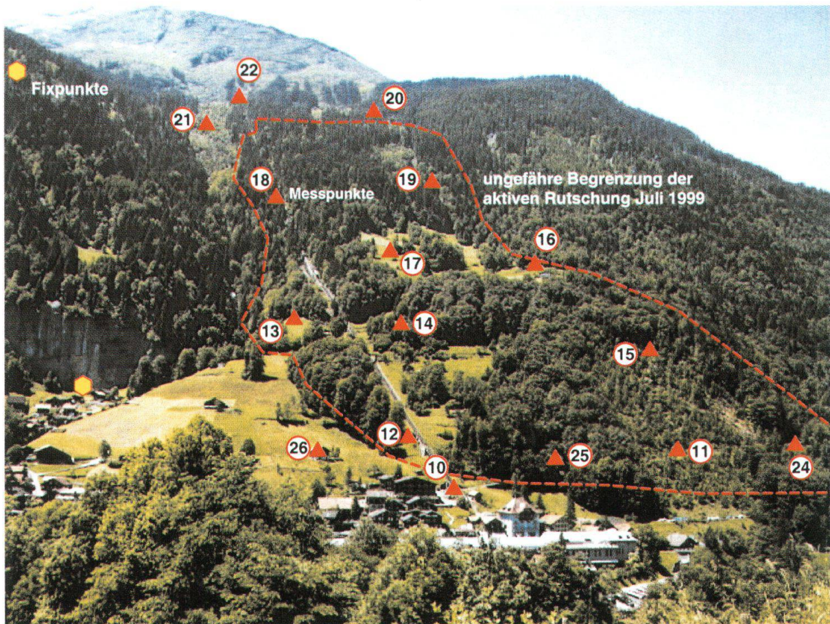
Fig. 1: Blick von Osten (Basisstation Distanzmessungen 853.16 m ü.M.) auf das Rutschgebiet Gryfenbach.
