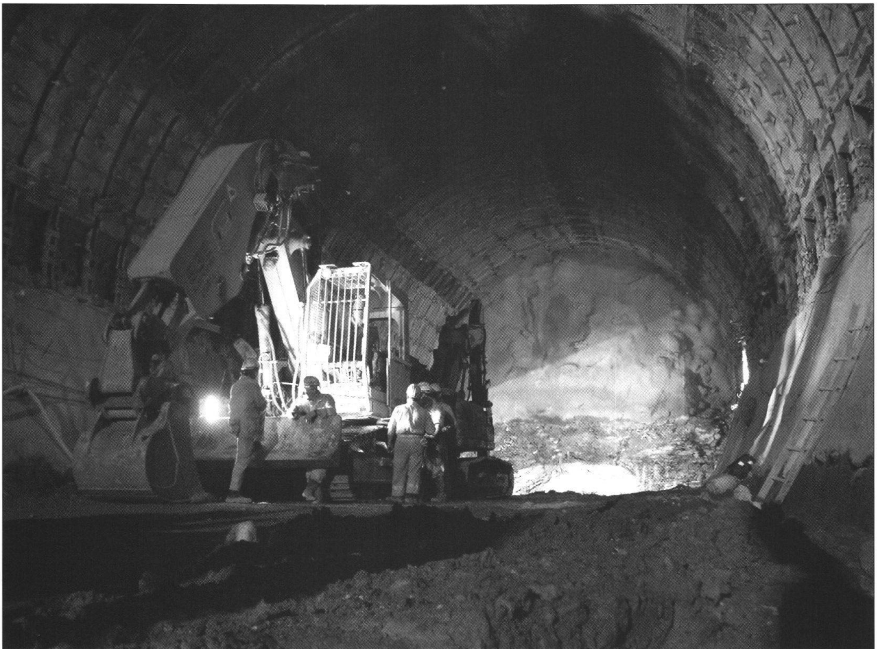
Fig. 2: NEAT in Faido: Maschinen und Personal sind für heute, während des Besuches der Fachgruppe für Untertagbau der SIA (und der VSP) untätig am Tunnelvorstoss. (Foto: Christine Pümpin)
