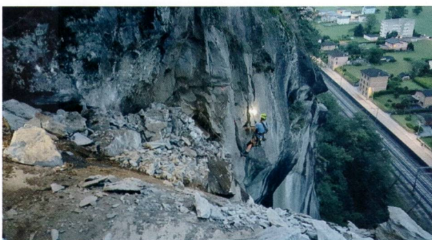
Fig. 8: Unmittelbar nach der Sprengung vom 23. Juli 2017 am frühen Morgen erfolgte die Felsreinigung. Rechts im Bild die SBB-Linie.
