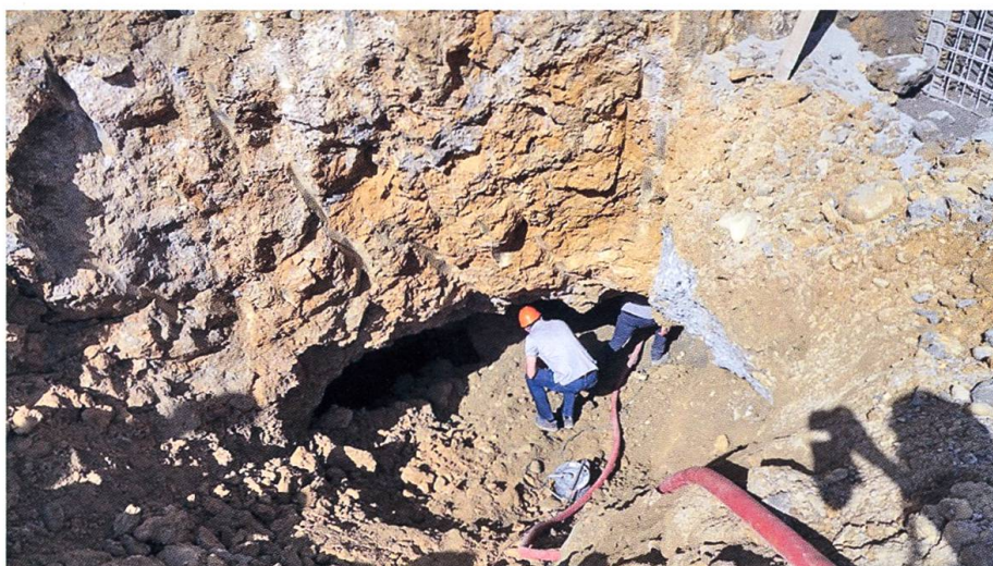
Fig. 5: Freigelegter Zugang zum Karsthohlräum (Bild Th. Rüegg, 04.08.2017).
