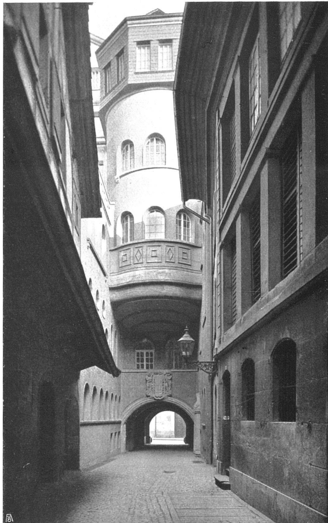
Volkshaus Bern Treppenhaus vom Gäßchen aus
