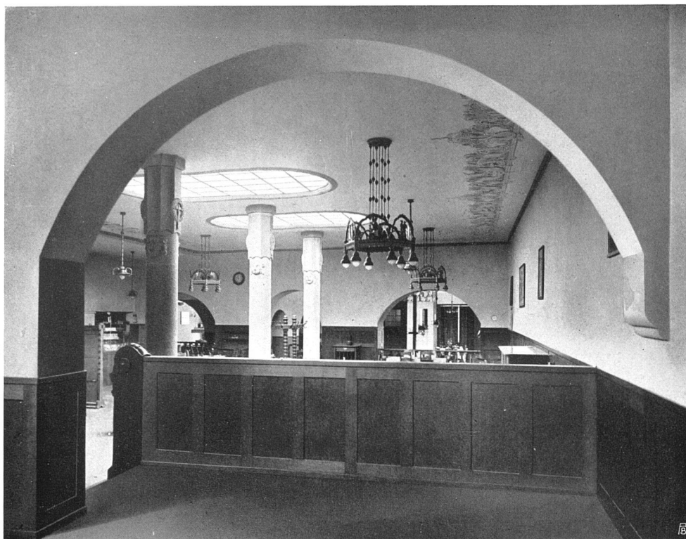
Restaurant Schmiedstube in Bern (Umbau)
