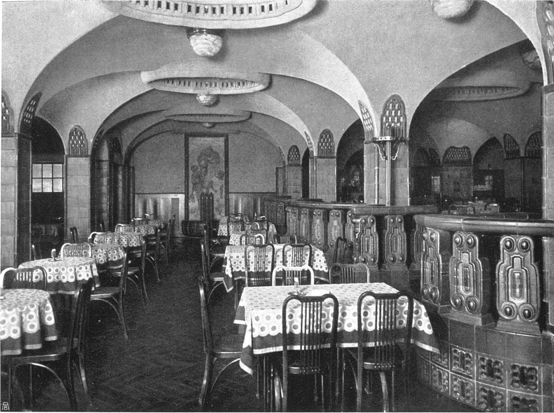
Volkshaus Bern. Großes Restaurant. Plattenverkleidung ausgeführt von Rob. Mantel S. W. B., Elgg
