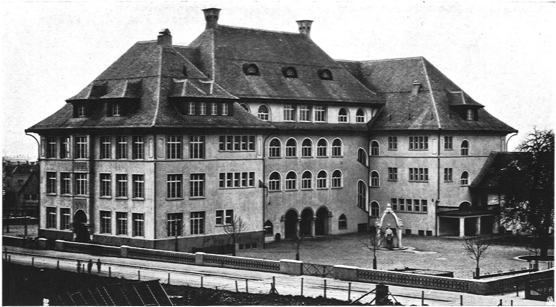
Lettenschulhaus in Zürich. Rückwärtige Ansicht mit Turnhof und Brunnen
