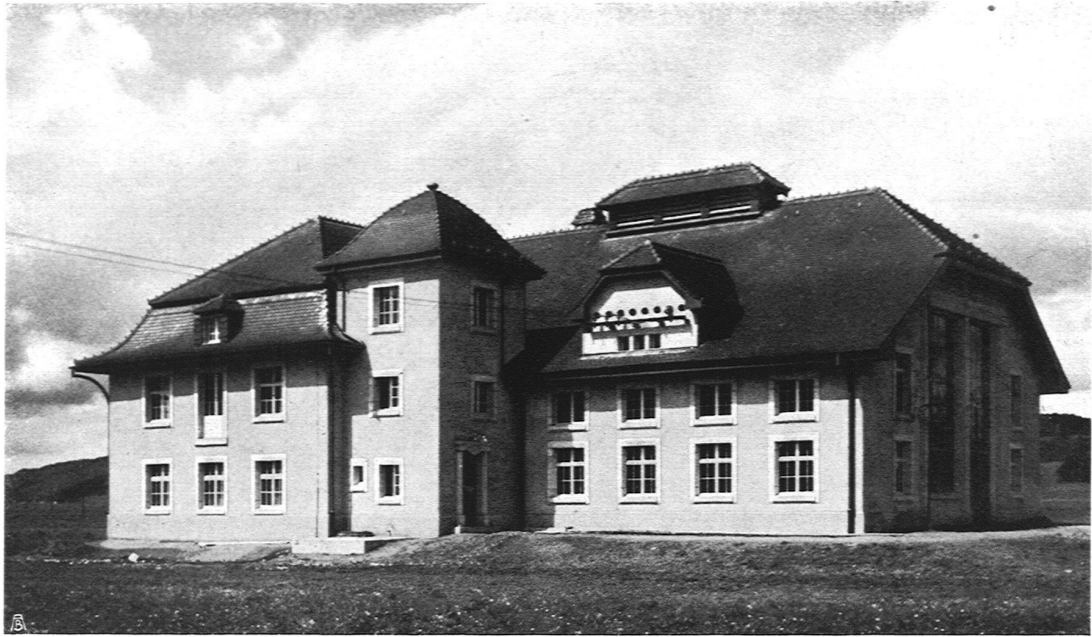
Bernische Kraftwerke. Umformerstation Bätterkinden, von Architekt Walter Bösiger, Bern
