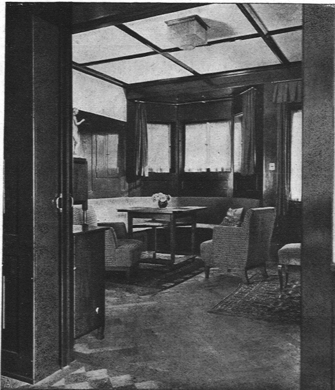
Wohnraum mit Eternit-Decken- füllungen
