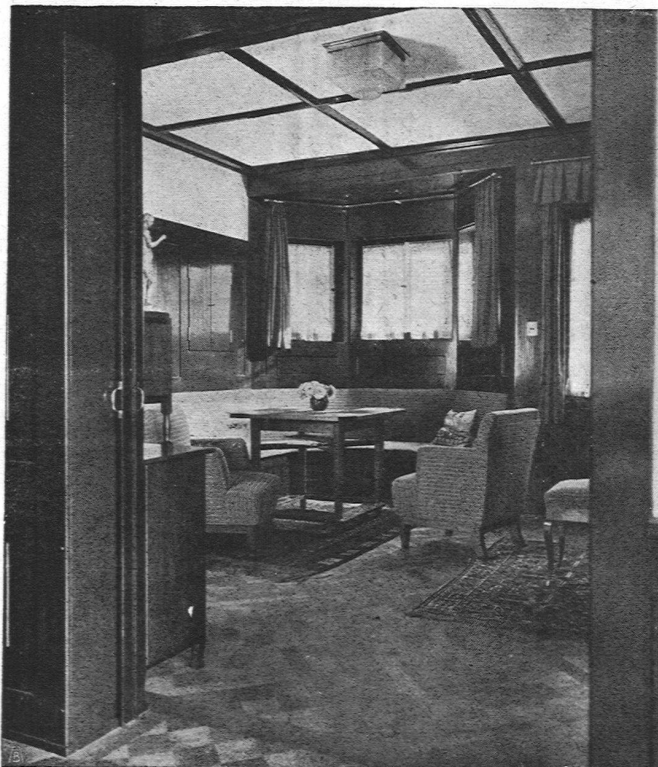
Wohnraum mit Eternit-Decken- füllungen
