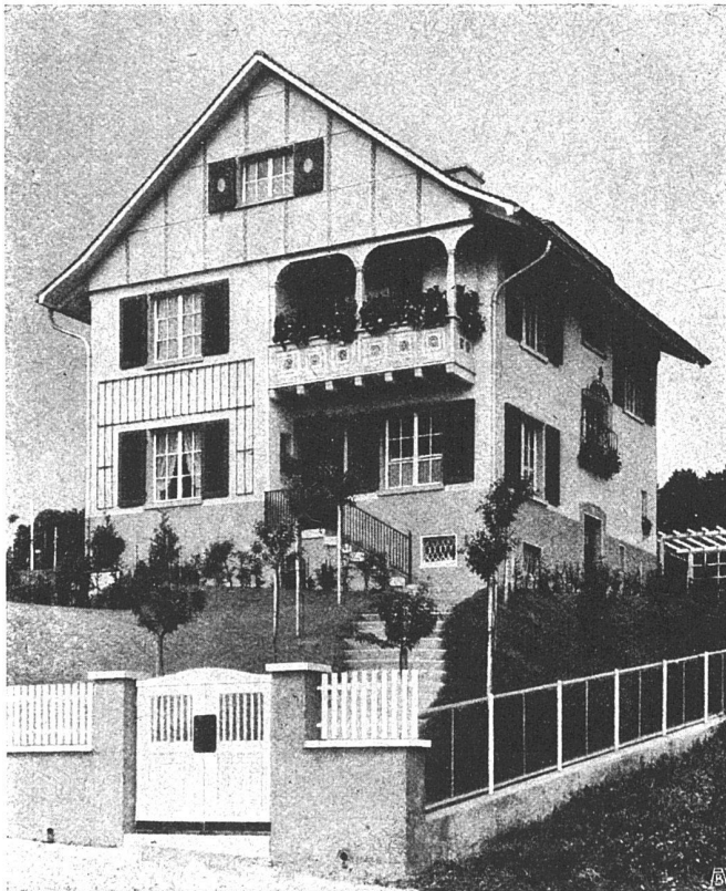
Haus mit Giebel- verkleidung aus Eternit
