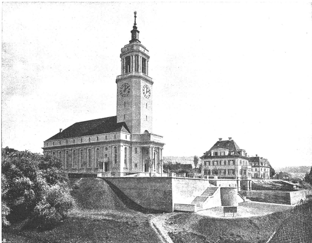
NEUE KIRCHE UND PFARRHAUS IN ZÜRICH-FLUNTERN
