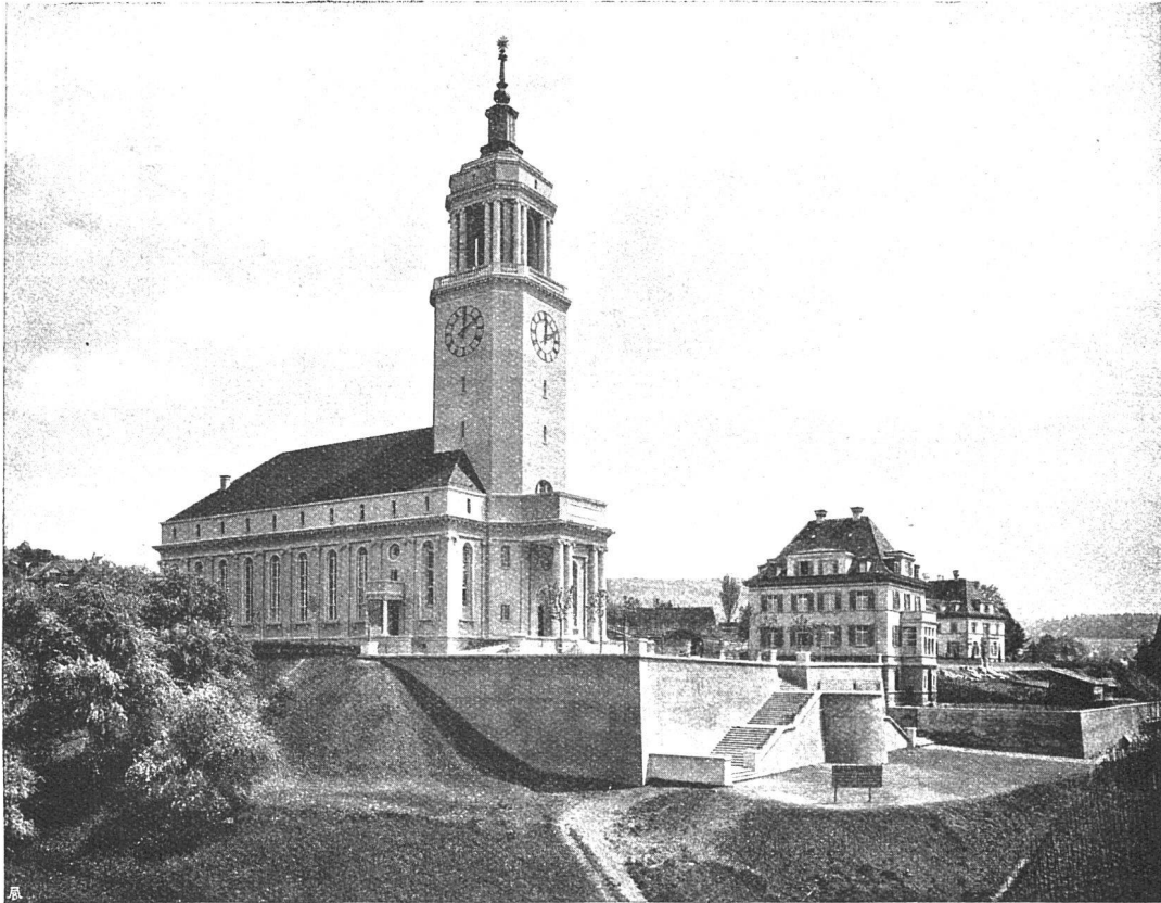
NEUE KIRCHE UND PFARRHAUS IN ZÜRICH-FLUNTERN
