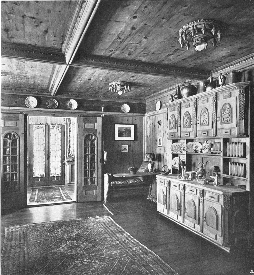
Haus Zay, Zuoz. Nikolaus Hartmann & Cie., Architekten und Baumeister, St. Moritz. Mitarbeiter: Nikolaus Hartmann, Arch. B. S. A., Emil Weber, Arch. Eßzimmer mit eingebautem Buffet in Arvenholz
