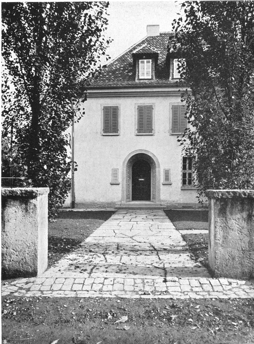
Landhaus in Rüslikon. Architekten Vogelsanger & Maurer B. S. A., Rüslikon Eingang von der Straße her
