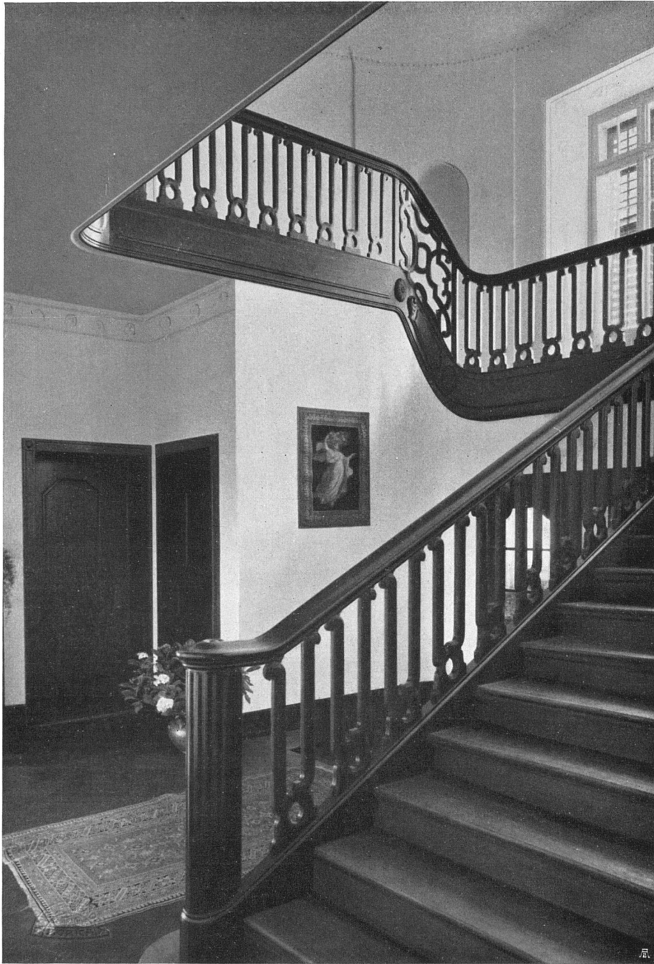
Villa B. Spinner, Kilchberg, Treppenaufgang. Schreinerarbeiten J. Keller, Möbelfabrik, Zürich; Parquetarbeiten Parquetterie Baden; Entstaubung Ziegler & Cie., Schaffhausen; Zentralheizung und Elektro-Warmwasserbereitung Gebr. Sulzer A.-G., Winterthur; Sanitäre Anlagen Deco, Zürich
