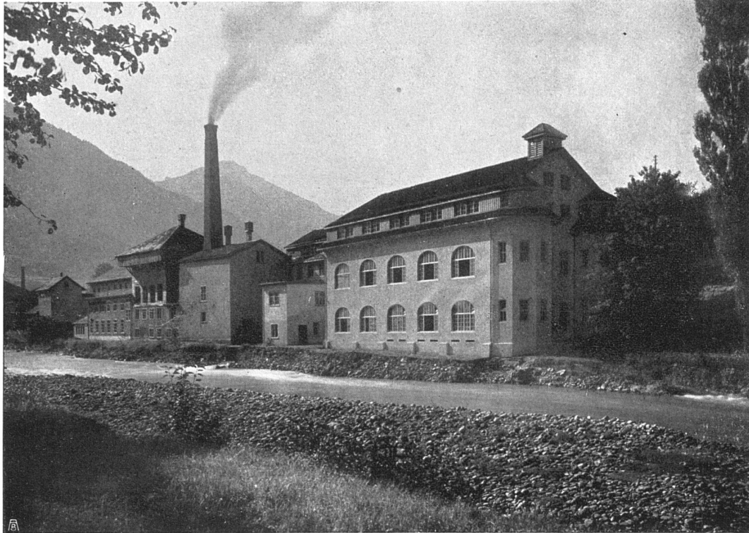
Fabrikneubau Hohlenstein Glarus. Architekt J. R. Streiff †. Terrasitverputz: Bammert & Schneider, Gipsler, St. Gallen Glaserarbeiten: Baer Söhne, Glarus; Boden- und Wandbeläge: Sponagel & Co., Zürich
