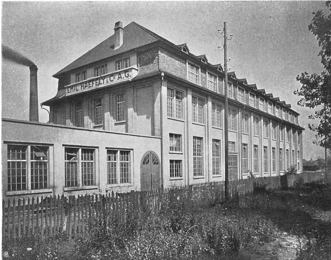
Wicklerei und Apparatenbau Emil Haefely & Cie. A.-G., St. Jakob bei Basel Architekten Widmer, Erlacher & Calini B. S. A., Basel
