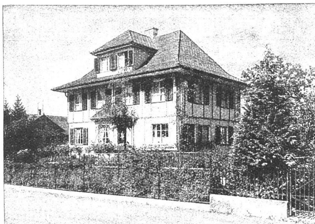
ETERNITHAUS IN WINTERTHUR NACH SYSTEM FRITSCHI & ZANGERL, ARCHITEKTEN
