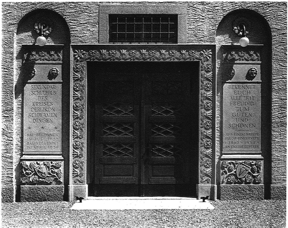
ABB. 7 NORDWESTLICHER EINGANG Bildhauerarbeiten von Otto Münch Ausführung der Türe durch M. Mayer-Mattes & Söhne, Zürich Phot. E. Linck
