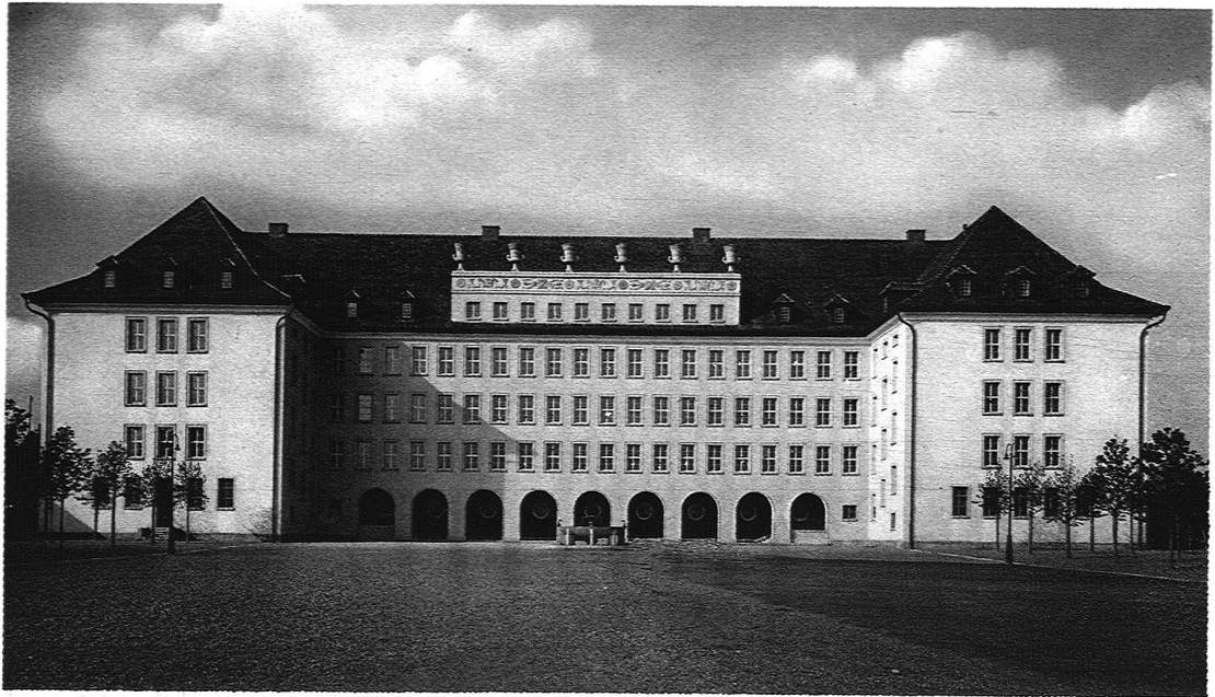
ABB. 2 HAUPTFASADE Phot. E. Linck
