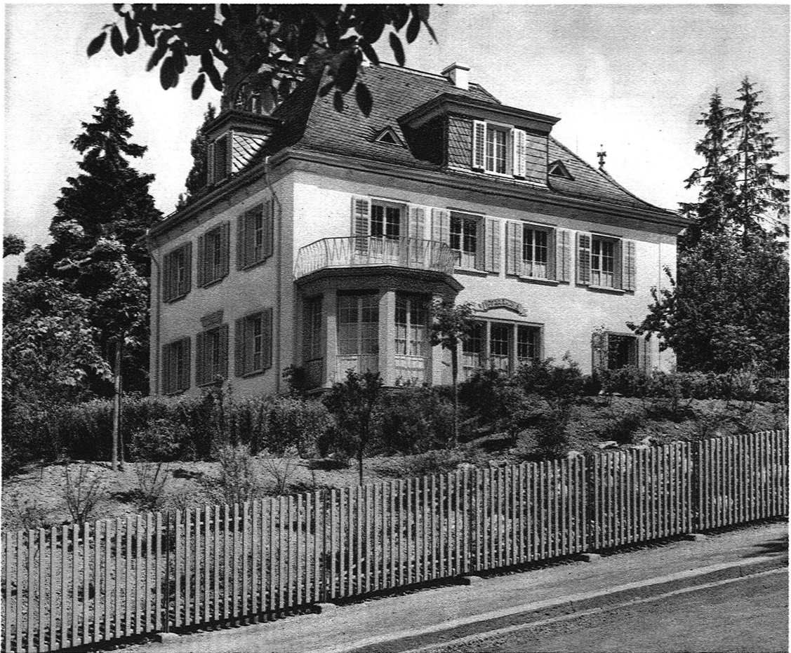
ABB. 7 HANS NAEF, ARCHITEKT, ZÜRICH NEUES PFARRHAUS ZÜRICH-UNTERSTRASS ANSICHT VON DER STRASSE - Phot. E. Linck
