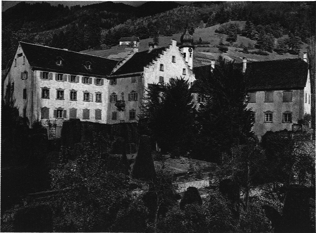
ABB. 2 SCHLOSS BOTHMAR GESAMTANSICHT VON SÜDWESTEN Phot. Albert Steiner, St. Moritz
