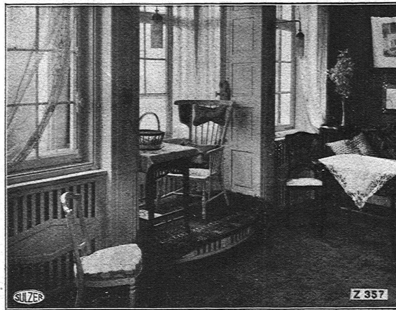
Abb. 12. Heizkörperaufstellung in den Fensternischen und dem Erker eines Wohnzimmers. Der Erkerfussboden wird durch einen Doppelboden und die darunter durchströmende Raumluft warm gehalten.
