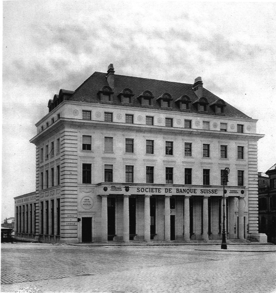
FIG. 16 SOCIÉTÉ DE BANQUE SUISSE, LAUSANNE ARCHITECTES : SCHNELL, THÉVENAZ F. A. S. ET BONNARD FAÇADE PRINCIPALE Phot. de Jongh
