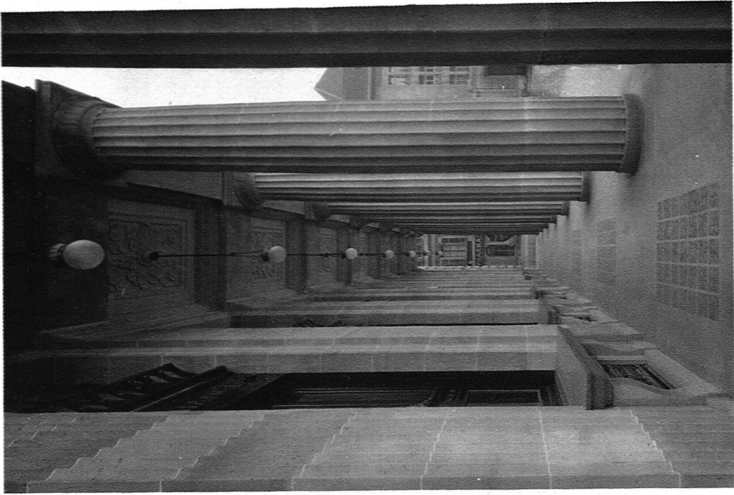
FIG. 18 PORTIQUE Phot. A. Kern
