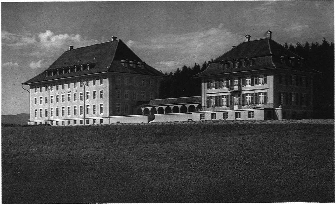
ABB. 7 LEHR- UND VERWALTUNGSGEBÄUDE VORDERE FRONTEN Phot. Henn
