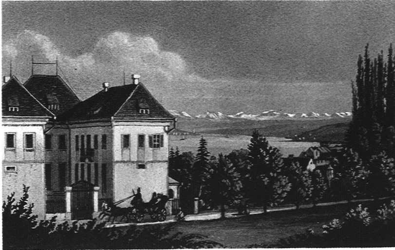
ABB. 1 ALTE ANSICHT DES MURALTENGUTES ZENTRALBIBLIOTHEK ZÜRICH
