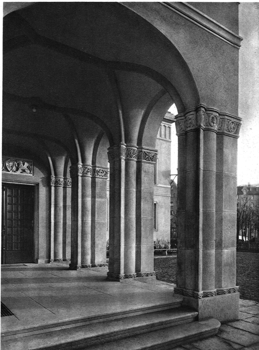
EINGANGSHALLE ZUM SAALGEBÄUDE / BILDHAUERARBEITEN VON OTTO KAPPELER ZÜRICH Phot. Wolf-Bender
