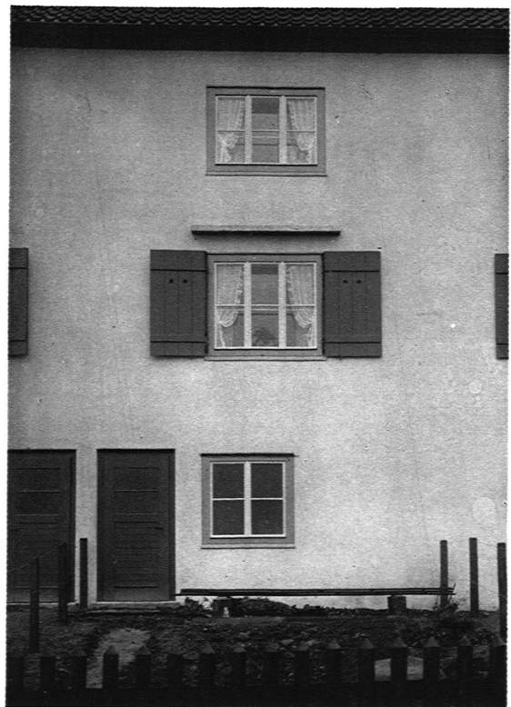
FRANZ SCHEIBLER, ARCHITEKT S.W.B. WINTERTHUR / EINFAMILIENHÄUSER AN DER JONAS FURRER-STRASSE / Detail der Gartenfront / Phot. M. Wirth, Winterthur
