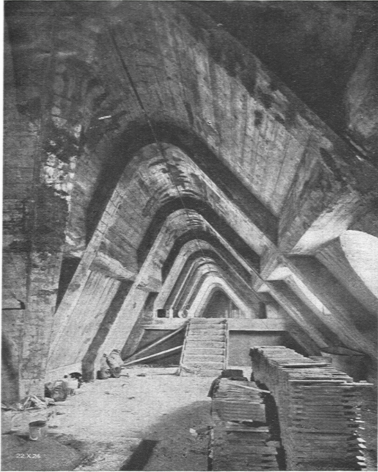
Abb. 6. Dachkonstruktion in armiertem Beton.
