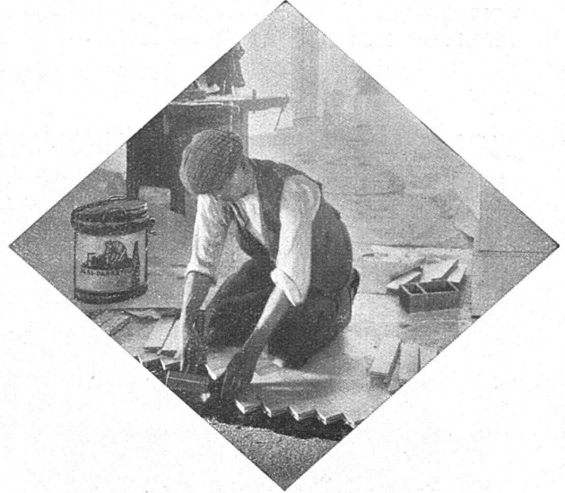
Abb. 14. Verlegen von Parkett in Igas-Kitt (6000 m 2 in der Eidg. Techn. Hochschule, 3500 m 2 in der Schweizerischen Nationalbank etc.).
