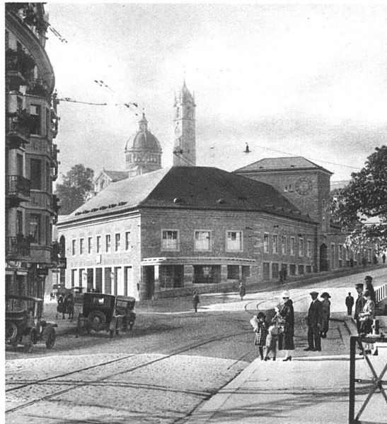
Blick vom alten Bahnübergang Enge auf die Ecke Seestrasse-Bederstrasse
