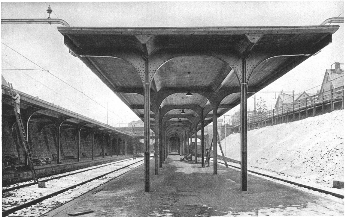
Perrondächer der Station Wiedikon, von Norden gesehen; im Hintergrund die Zweierstrassenbrücke
