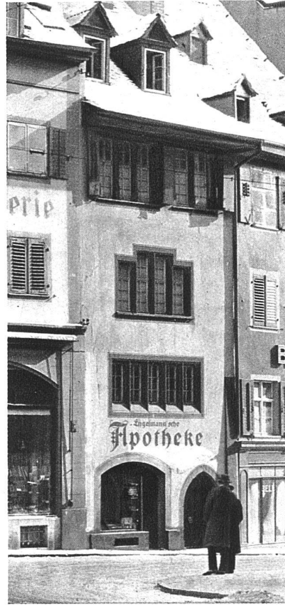
NACH DEM UMBAU
