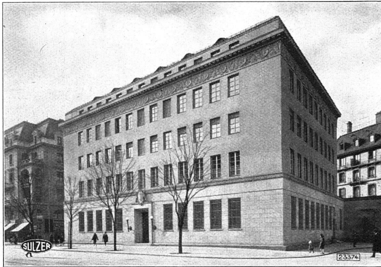
Schweiz. Nationalbank, Zweiganstalt Luzern. Sulzer-Pumpen-Warmwasserheizung, Warmwasserbereitung, Tresorheizungs- und Lüftungsanlage.
