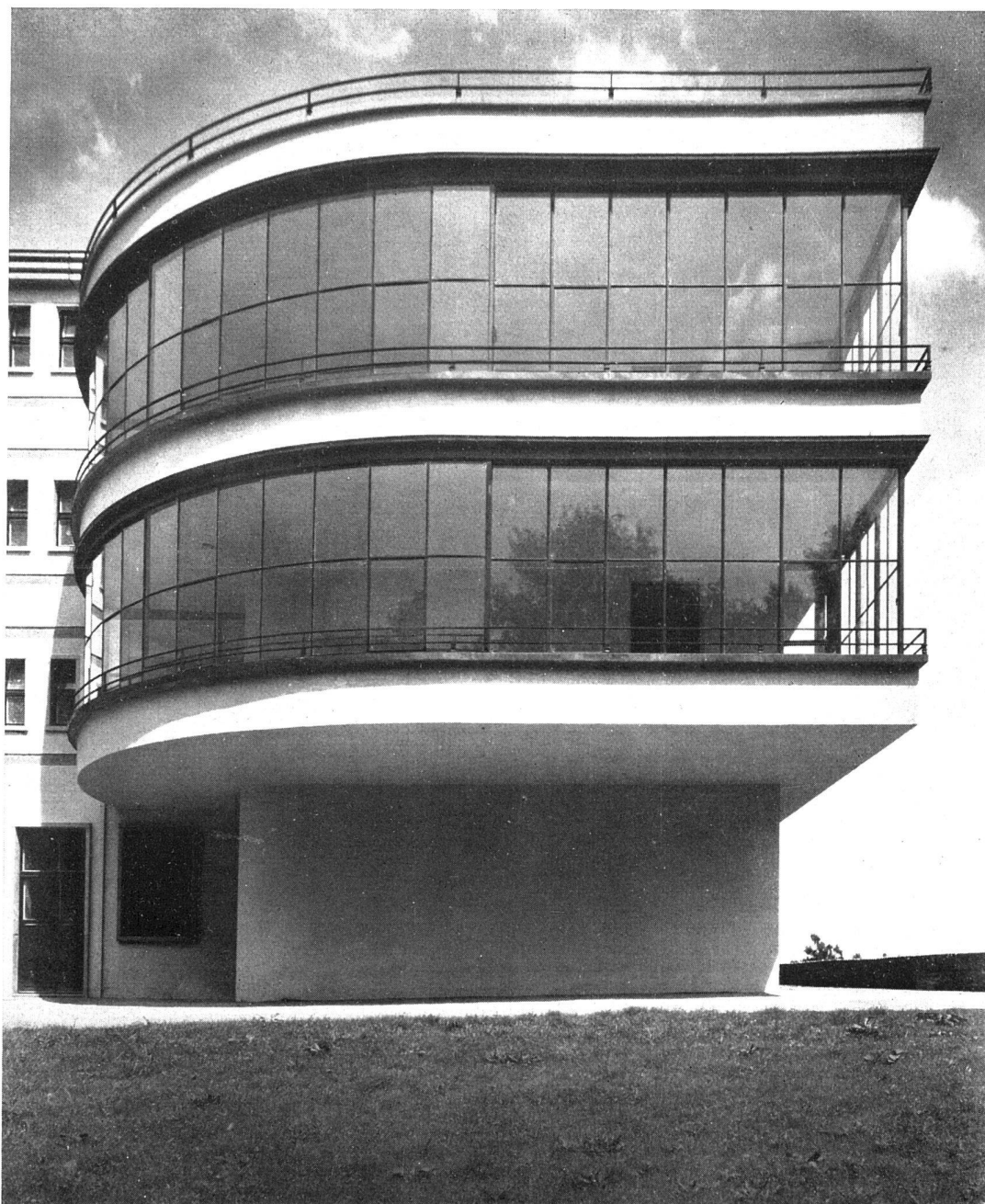
LOROSPITAL / LIEGEVERANDEN GESCHLOSSEN, MIT DARÜBER BEFINDLICHEM SONNENBAD
