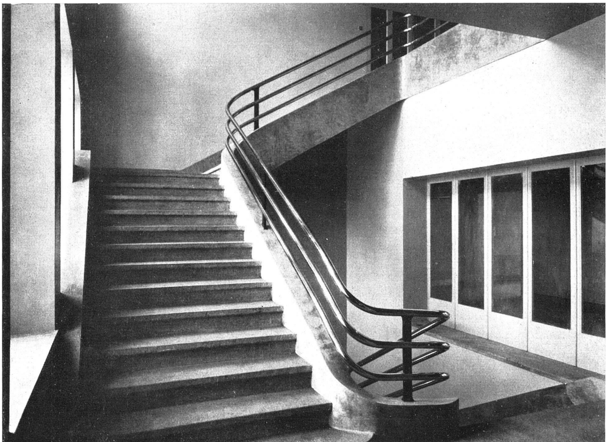
LORYSPIITAL / GRANITTREPPE MIT STUCCOLUSTRO-WANGE UND NICKELGELÄNDER
