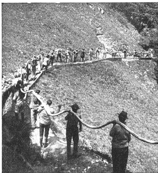
Fernkabelverlegung am Walensee
