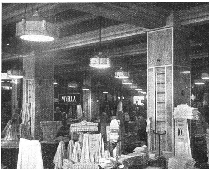
TEILANSICHT EINES RAUMES IN EINEM KAUFHAUSE IN MANCHESTER DIE EISERNEN SÄULEN SIND MIT PLYMAX UMMANTELT
