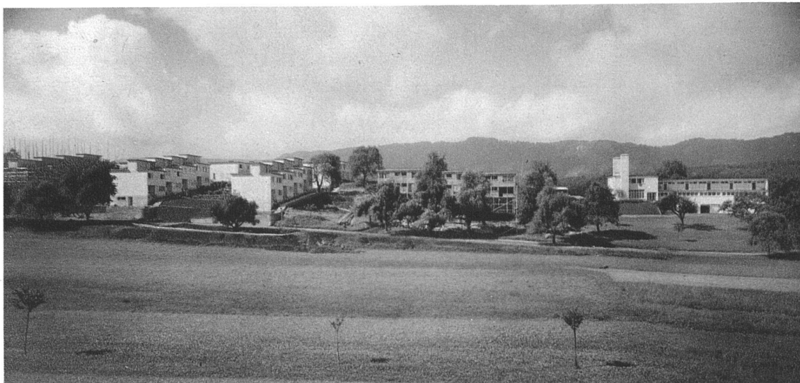
Werkbundsiedlung Neubühl, Zürich, dahinter der Uetliberg links: gestaffelte Wohnzeilen, Typ A Mitte: Atelierhaus rechts: Ladenhaus, Fernheizwerk und Aussengang-Wohnungen
