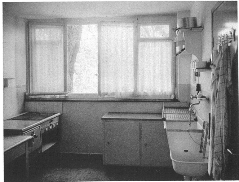
Küche der Typen A und C (grösster Küchentyp, auch für event. Dienstboten) Bodenbelag: Dermo-Steinholz
