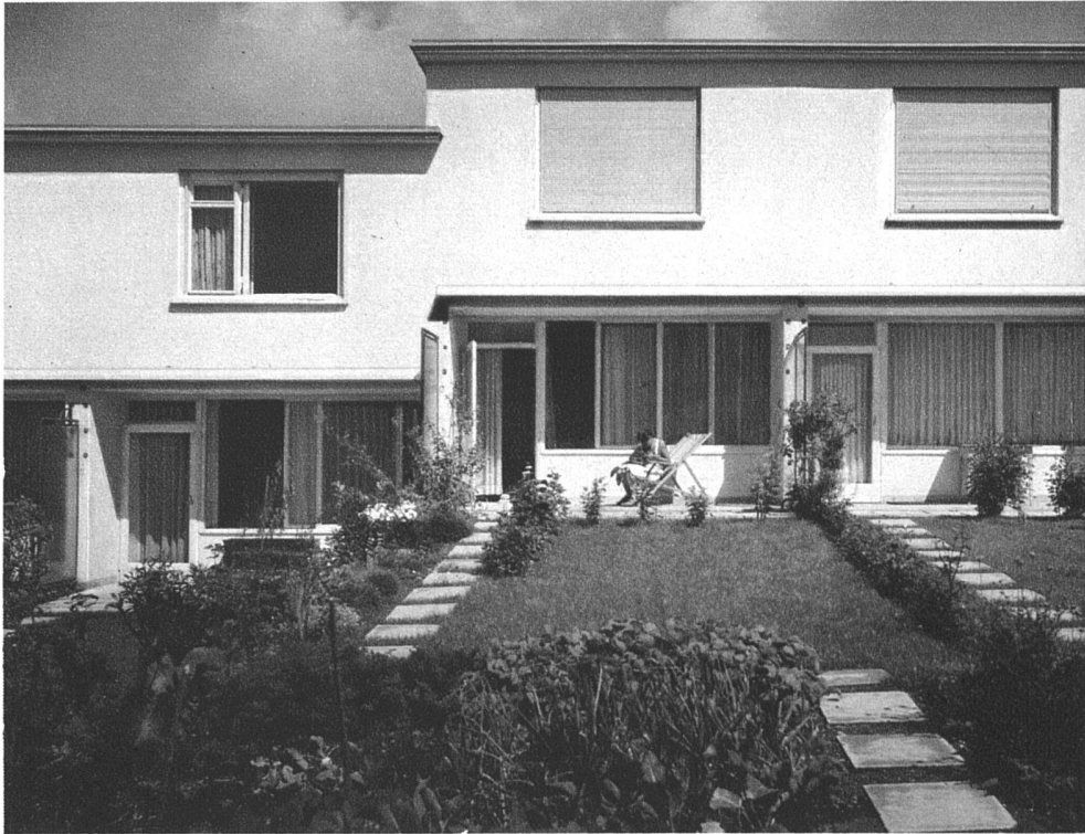
Werkbundsiedlung Neubühl, Zürich Dreizimmer-Reihenhaus Typ D Südseite einer nach Westen abgestaffelten Reihe
