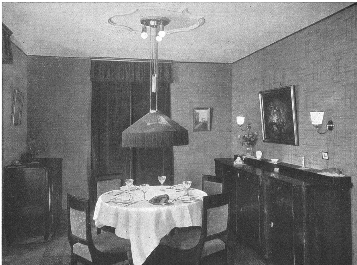
Esszimmer richtig beleuchtet. Ueber dem Tisch genügend tiefer Schirm, aus goldgelber Seide, innen weiss gefüttert mit hinterfütterten Fransen. Allgemeinbeleuchtung des Zimmers durch drei an der Decke befindliche Opalglaslampen. Schwache Blendungsgefahr, daher die Glühlampen zweckmässiger in lichtstreuende Hüllen einschliessen. Ueber dem Buffet zwei Wandleuchten mit gut lichtstreuenden Kelchen, welche die Glühlampe vollkommen verbergen.
