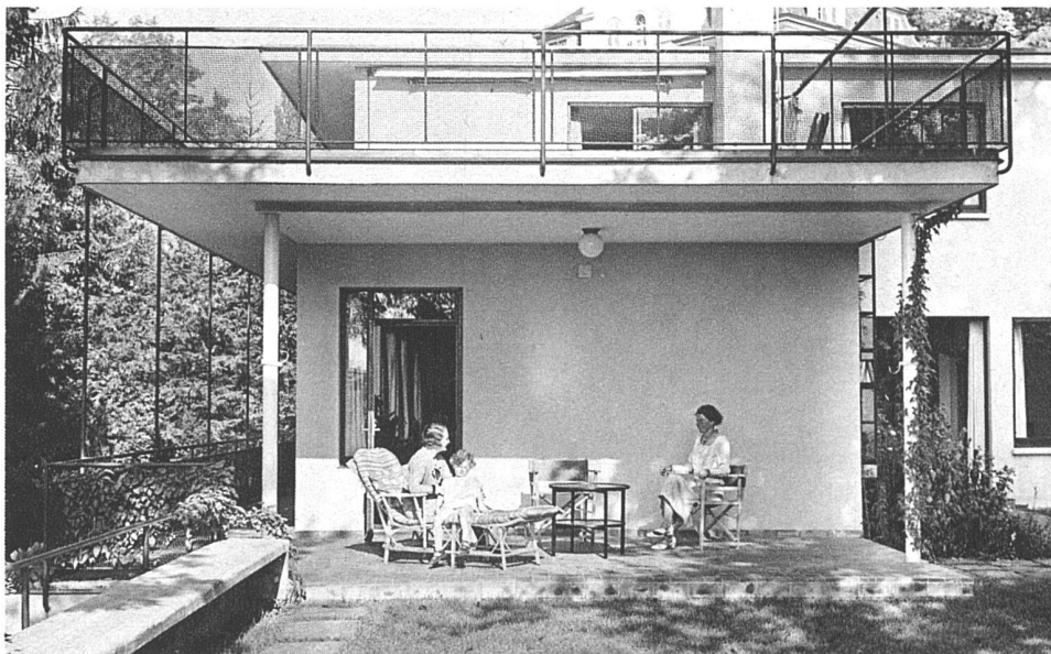
Esszimmervorbau von Südosten
