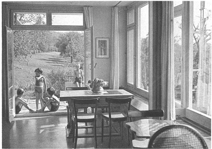
östliches Haus die Südecke von innen
