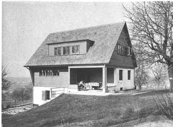
Ansicht aus Südosten
