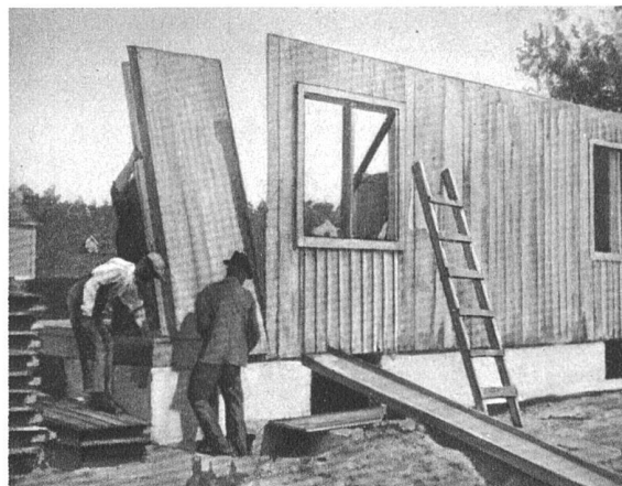
Sesamhaus im Bau
