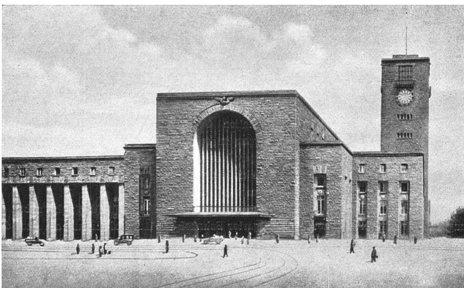
Der neue monumentale Hauptbahnhof in Stuttgart
