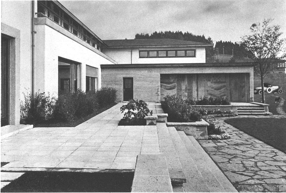
Südwestansicht, links Speisesaal, frontal Officetüre und Terrasse
