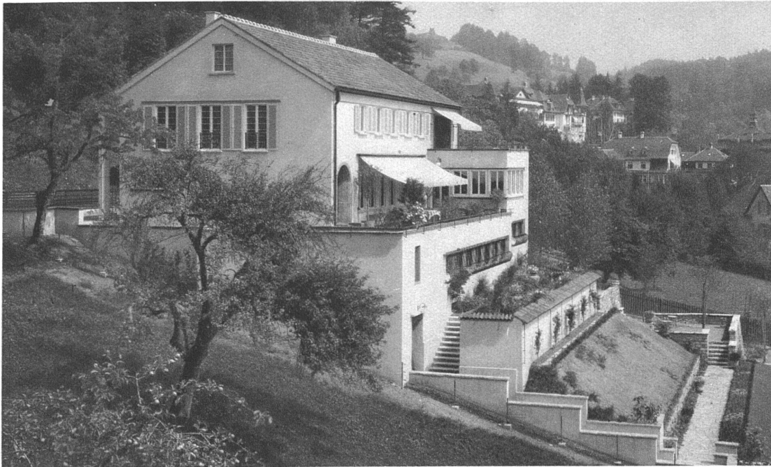
Ansicht aus Südosten
