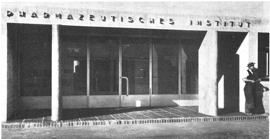
Einer der fünf Institutseingänge (Pharmazeutisches Institut) Material der Pfeiler geschliffener grüner Kunststein, Türen Anticorodal
