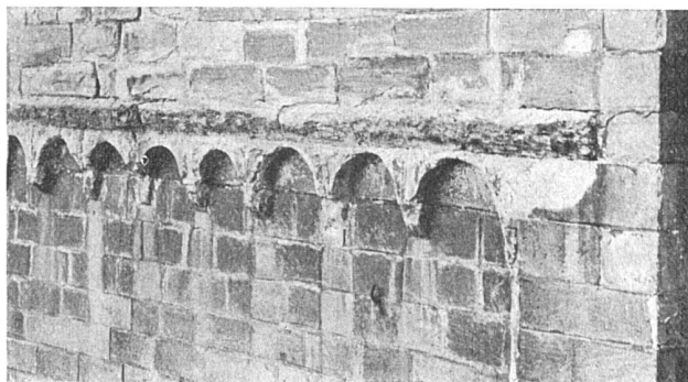
Der Chorgiebel vor der Wiederherstellung unten: Verwitterungszustand des Bogenfrieses
