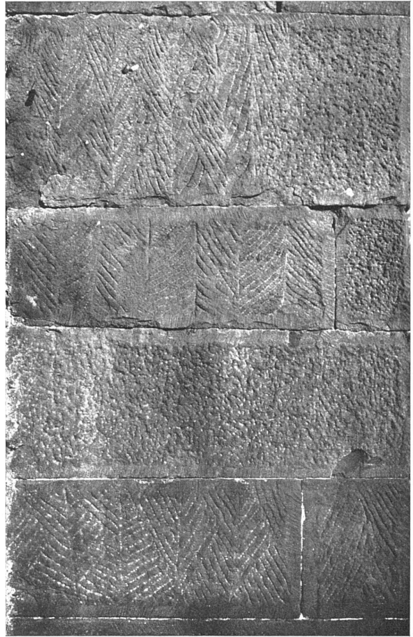
Gemustert abgespitztes Quaderwerk der Abteikirche zu Limburg an der Hardt
