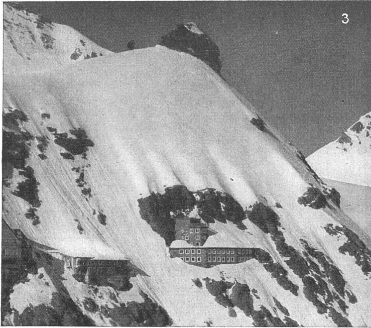
Hochalpine Forschungsstation Jungfraujoch Asphaltoid-Isolierung der Terrassen ca. 420 m 2
